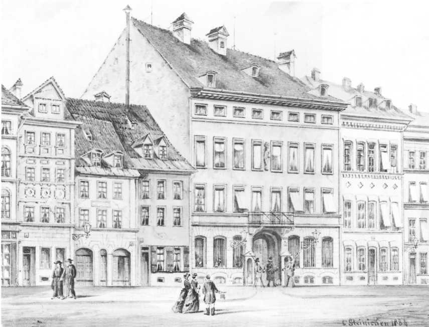
Ansicht des Landtags in der Prannerstraße vor dem Umbau, 1884
